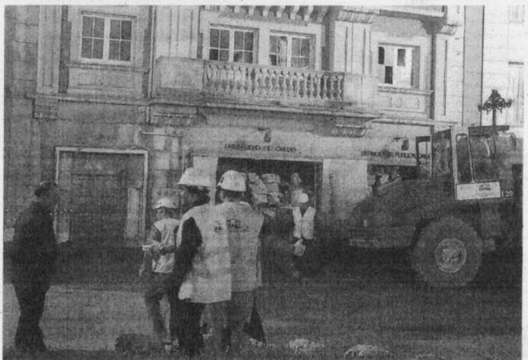
▲ Los trabajos. Ayer por la noche ya empezaron las labores de derrumbe de la fachada
